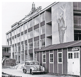
De bouw van bejaardencentrum De Engelenburgh in 1963/1964.
